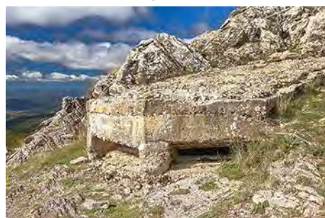
Exterior del búnker bajo la antecima Sur
