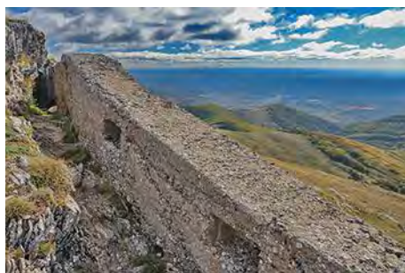
Parapeto de hormigón dominando el Sur
