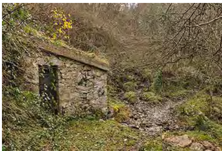
Caseta de aguas, la parte más embarrada
