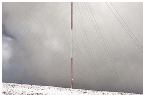
La antena, pasaremos muy cerca de ella
