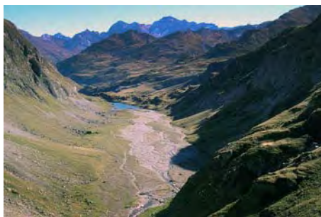
La presa al fondo con el Perdido detrás
